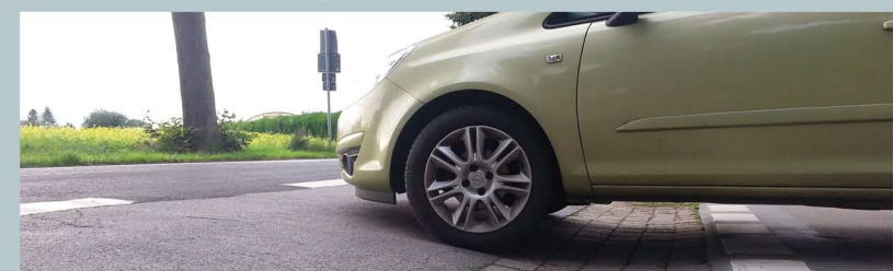
Anrather Friedhof: Auf meinen Antrag hin werden die Zufahrten abgesenkt, sodass die PKWs nicht mehr auf dem Asphalt aufsetzen.
